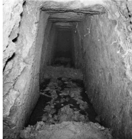
Erzstollen südlich der Ravelle. Breite 1.2 m, Höhe 2.2 m. Foto Kuno Blaser 1958
