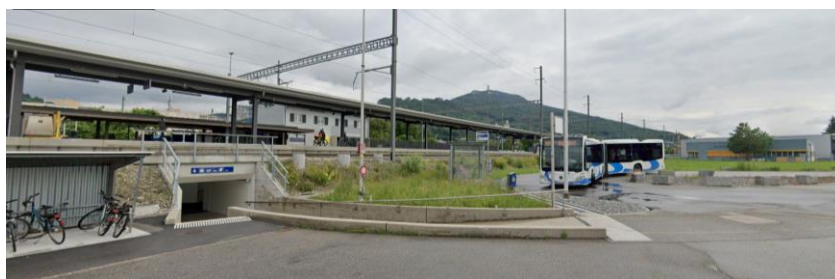
Abbildung 5: Bahnhof-Unterführung zu den Gleisen (Quelle: google streetview)
