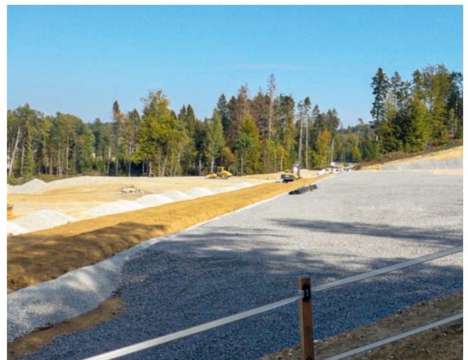
1. Etappe: Flächenfilter, darunter Abdichtung (Stand September 2018)
