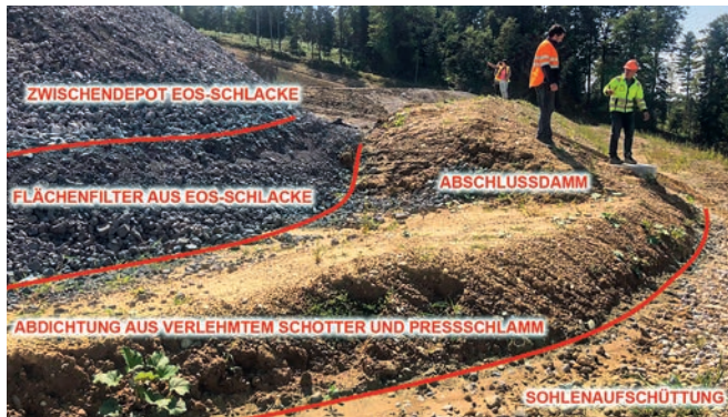
Aufbau der Deponie (Stand September 2020)
