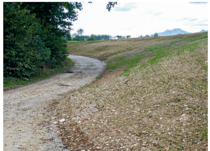
1. Etappe: Bodendepot mit einem 1.5 m hohen Ober- und Unterboden (Stand August 2020)
