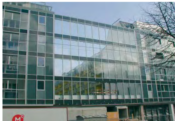
Wind- und Lärmschutz zwischen Gebäuden
