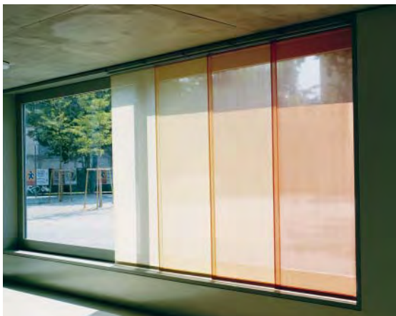
Mit Flächenvorhängen in unterschiedlichen Farbtönen lässt sich spielen! Jedoch: Je höher der Reflexionsgrad der Scheiben, desto geringer ist die Wirkung innen montierter Gardinen.
