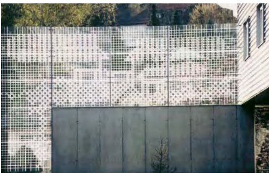
Von Künstlerin gestaltete Schallschutzwand am Remisenhof, Linz (© Hil de Gard)
