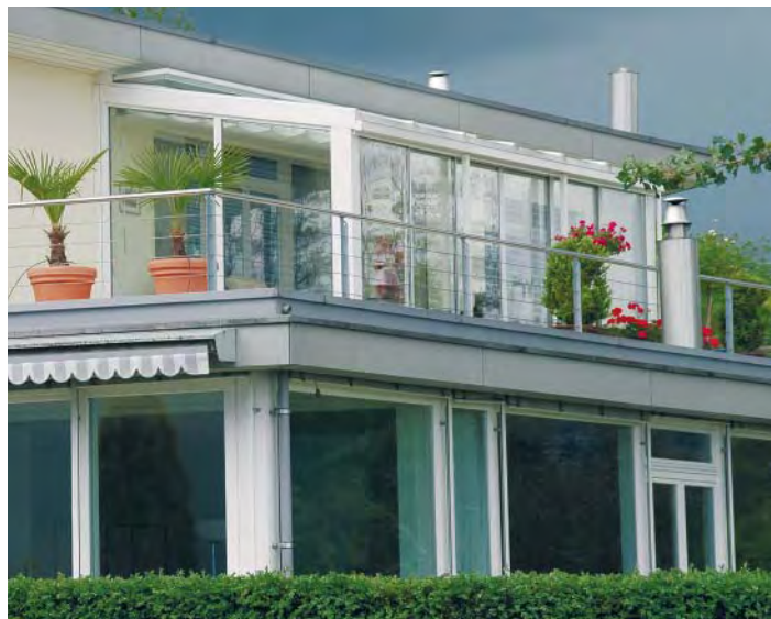
Wintergarten, verglaster Wohnbereich
