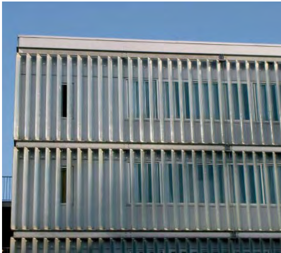
Vertikale oder horizontale Lamellen erzeugen einen Schattenschwurf und gliedern die Fassade. So erkennen die Vögel die Fassade als Hindernis.
