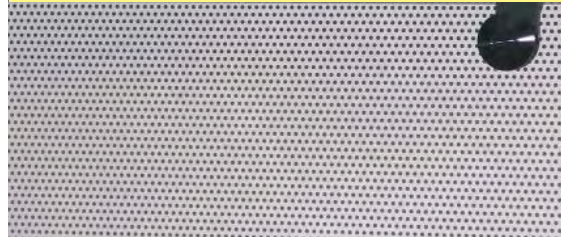
Muster einer solchen Bedruckung auf einer Überdachung aus Glas.
