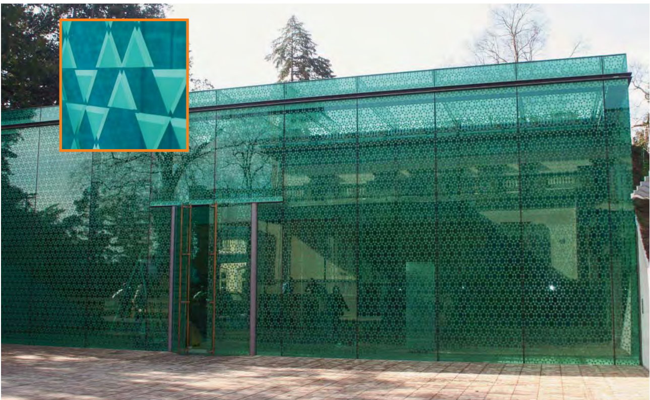
Dieser neue Vorbau des Rietberg-Museums in Zürich befindet sich mitten in einem Park. Er wurde – nicht zuletzt aus Vogelschutzgründen – mit durchwegs bedrucktem Glas realisiert und als «Smaragd» bezeichnet. Wahrlich ein Schmuckstück!
