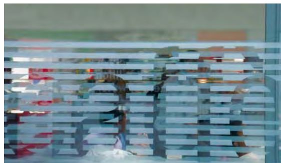
Sichtschutz für die Gäste und Werbemittel in einem: großflächig bedrucktes Glas in einem Strassencafé.
