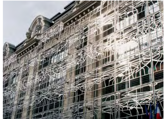
Vorgehängte Gitterstruktur am Ministère de la culture in Paris: Kunst am Bau und Vogelschutz.
