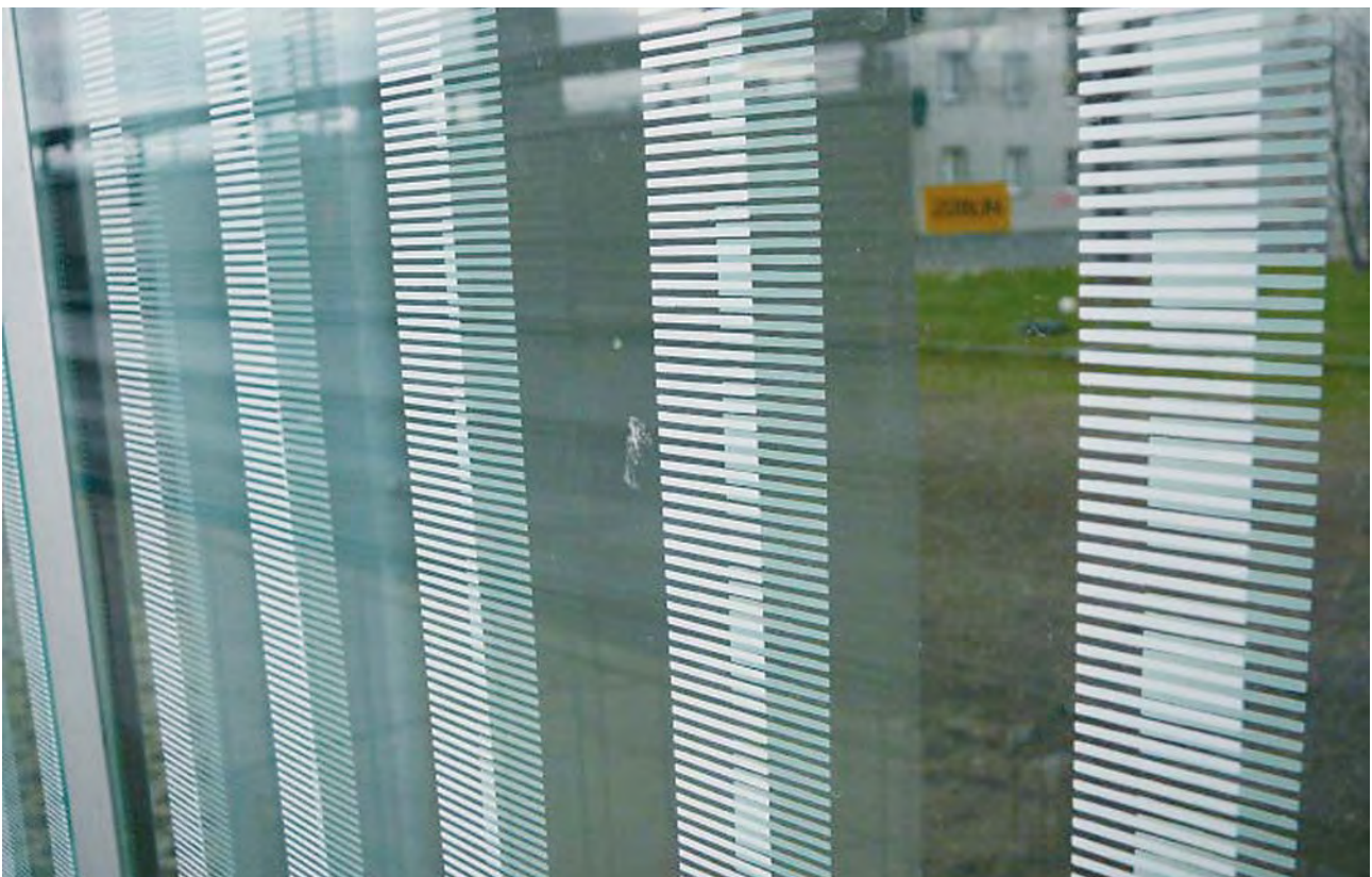
Eine Detailaufnahme der oben abgebildeten Wand. Der Siebdruck – 2 cm breite unterbrochene Streifen in 10 cm Abstand – wurde beidseitig aufgebracht und teilweise auf der Rückseite etwas verbreitert, was bei der Annäherung den 3D-Effekt verstärkt.
