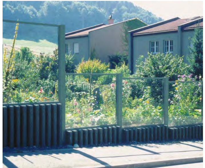
Hochgradig problematisch: Eine transparente Lärmschutzwand, dahinter ein vielfältiger Naturgarten.
