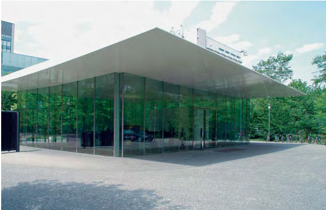
Empfangsgebäude eines grossen Industriebetriebes. Die optische Verknüpfung von Innen- und Aussenraum ist für Vögel höchst gefährlich.
