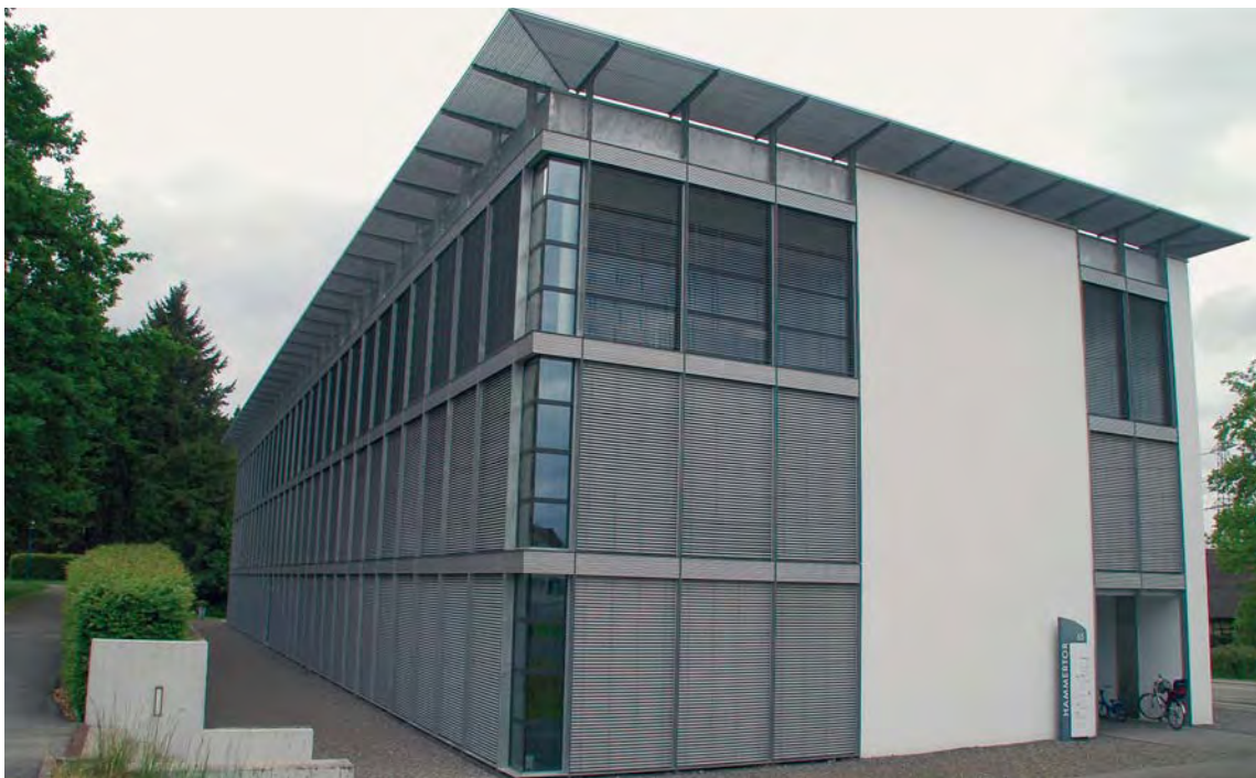
So ist es richtig: Die Jalousien sind an Wochenenden und nach Arbeitsschluss geschlossen.
