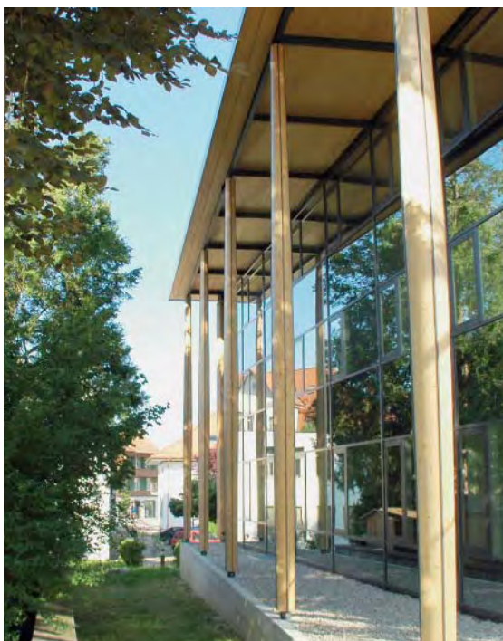
Bei diesem Bankgebäude machte die Denkmalpflege Auflagen. Stark spiegelndes Glas sollte die benachbarte Kirche schön zur Geltung bringen...
