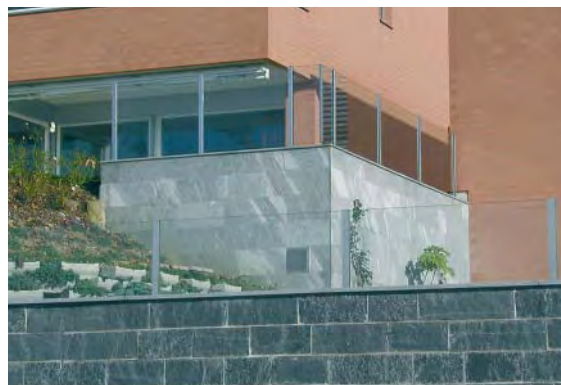
Balkonverglasung und Lärmschutzwand
