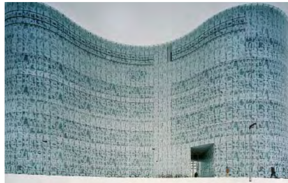
Gebäude der Brandenburgischen Technischen Universität Cottbus mit flächiger Bedruckung.
