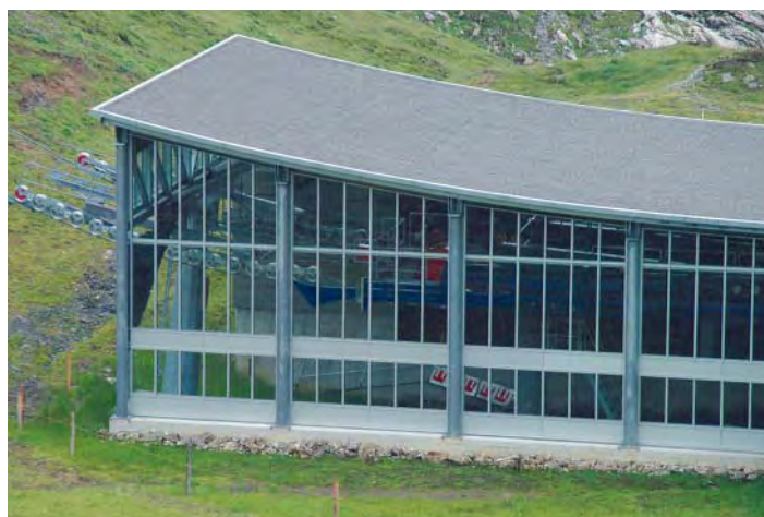
Auf drei Seiten verglaste Talstation einer Bergbahn: Vögel flüchten sich bei spätem Schneefall ins Gebäude und prallen meist von innen an die Scheiben.
