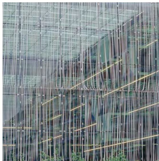
Als Notmassnahme wurden an diesem Gebäude helle Plastikstreifen vorgehängt.
