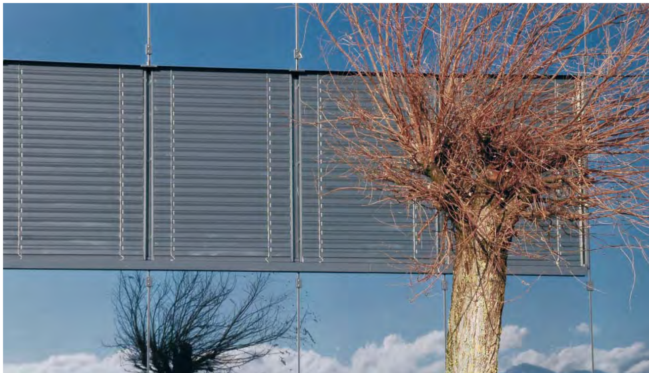
Bedauerlicherweise gibt es gerade bei öffentlichen Bauten viele schlechte Beispiele: Spiegelfassade an einem Gemeindehaus.
