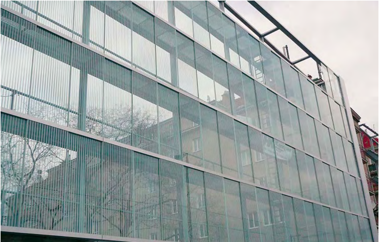
Diese Lärmschutzwand am Theodor-Körner-Hof in Wien wurde kürzlich errichtet, um das lärmgeplagte Wohnquartier zu schützen und aufzuwerten. Es ist ein Musterbeispiel für vorbildlichen Vogelschutz, zumal die aufgebrachten Strukturen zuerst im Flugkanal getestet wurden und dort mit ihrer sehr hohen Erfolgsquote überzeugten.
