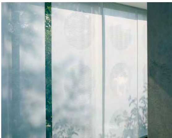
Lichtdurchlässige Flächenvorhänge sind wirkungsvoller als Nachtvorhänge, da sie immer zugezogen sind. Sie wirken allerdings nur bei reflexionsarmem Glas.
