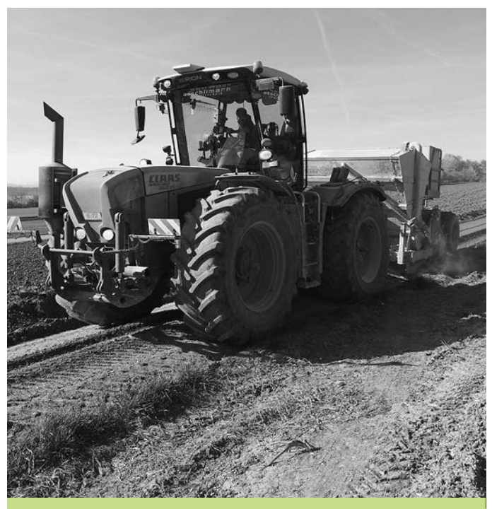
Einbau des Spezialbindemittels mit Fräs-Streukombination
