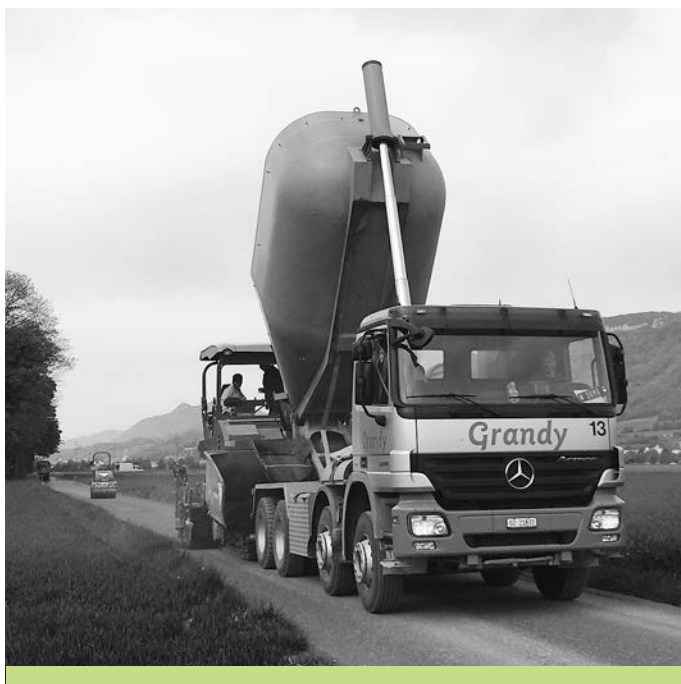
Einbau des Asphaltbelags ACT 16 TDS
